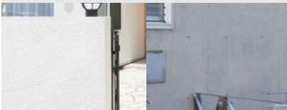
塗り壁仕上げ コンクリートブロック
